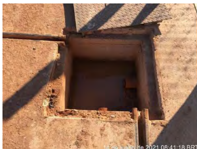
Foto 329 – Vistoria na 1º Caixa de Inspeção e retenção de sedimentos. (Data: 14/06/2021)
