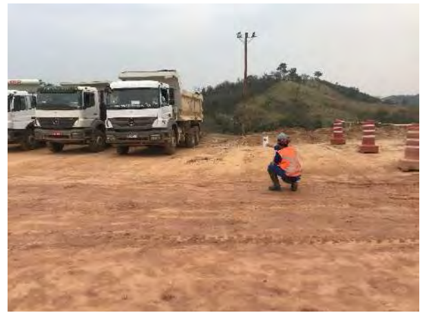
Foto 359 – Inspeção de fumaça preta do Gerador. (Data:30/09/2021)
