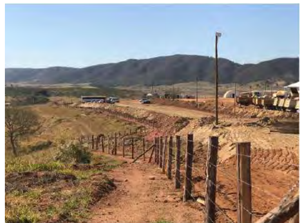
Foto 323 – Talude, leira e gramíneas, vista Leste face norte. (Data:27/07/2021)
