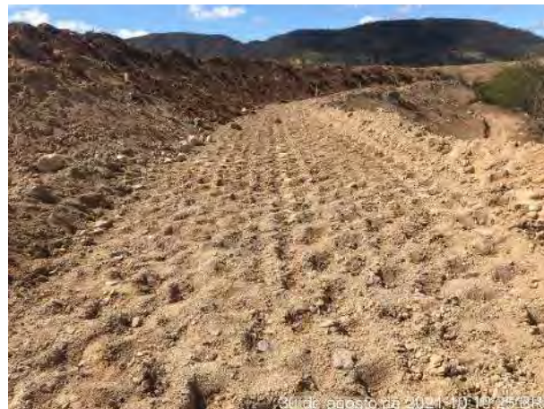
Foto 275 – Solo compactado e inclinação para berma. (Data: 30/08/2021)
