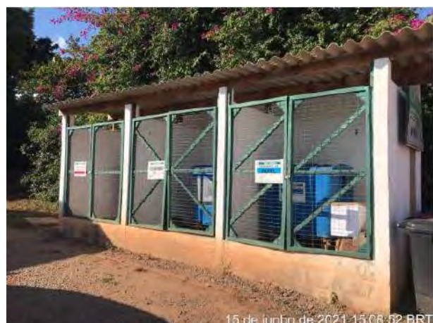
Foto 373 – Baía de armazenamento de resíduos. (Data:15/06/2021).
