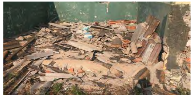
Foto 18. Telhas com amianto
