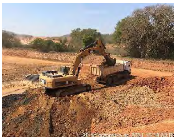
Foto 396 – Compactação de solo do Bota Fora 02 M.D. (Data:20/09/2021)
