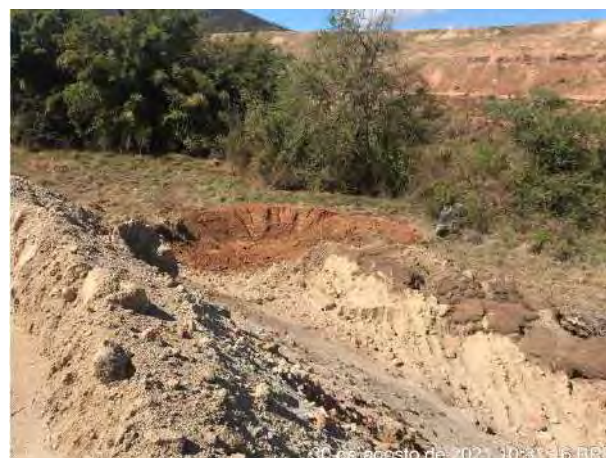
Foto 281 – Abertura de Cacimba de contenção Bota Fora 02. (Data: 30/08/2021)
