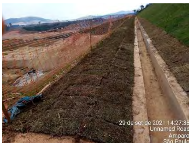
Foto 315 – Germinação grama em placa e canaletas. (Data: 29/09/2021)
