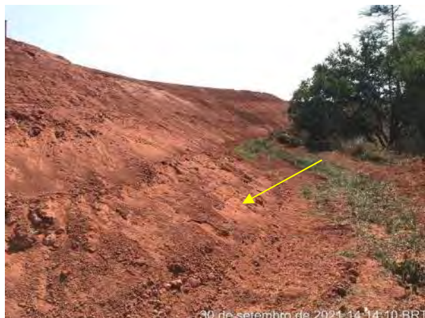
Foto 232 – Vista para inclinação e direcionamento do platô. Leira de solo entre as bermas do talude do bota espera. (Data:30/09/2021)
