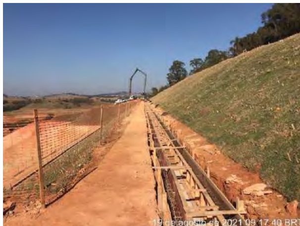
Foto 307 – Abertura das canaletas de drenagem. (Data: 19/08/2021)
