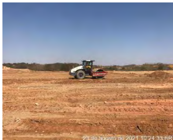
Foto 393 – Compactação de solo do Bota Fora 02 M.D. (Data:23/08/2021)
