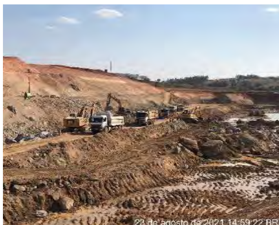
Foto 395 – Movimentação de terra na M.E Galeria. (Data:23/08/2021)
