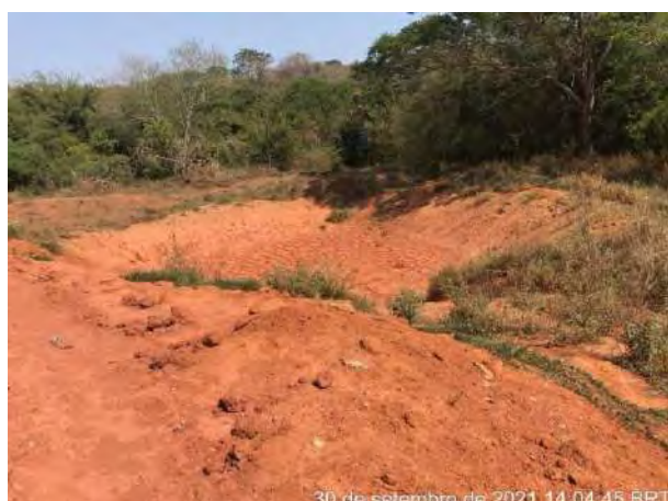
Foto 236 – Cacimba de retenção de particulado. (Data:30/09/2021)
