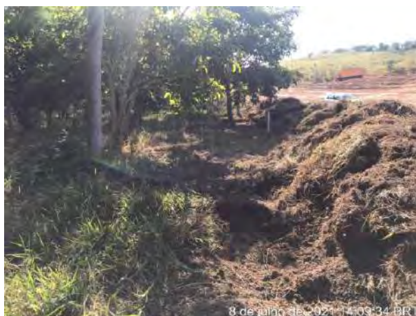
Foto 264 – Implantação de leira com gramíneas no entorno do Bota Fora 02. (Data: 08/07/2021)
