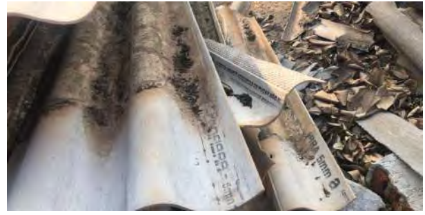
Foto 20. Telhas com amianto
