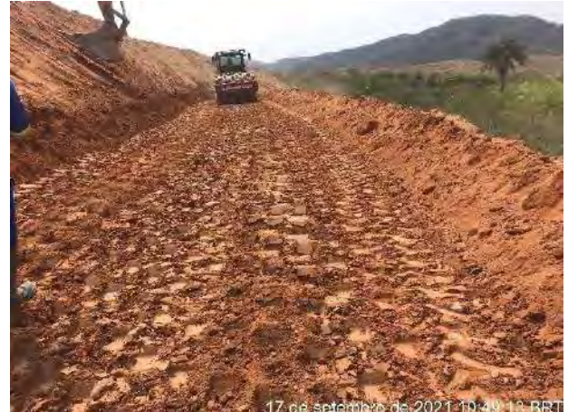
Foto 258 – Equipe implantando os dispositivos de drenagem provisórios. (Data: 17/09/2021)
