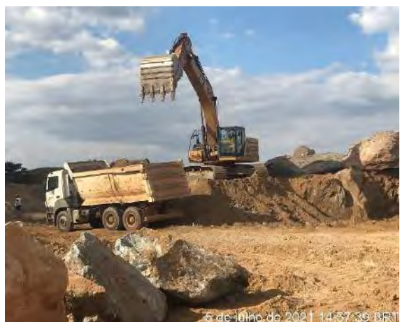
Foto 388 – Movimentação de terra na M.E Galeria. (Data:05/07/2021)
