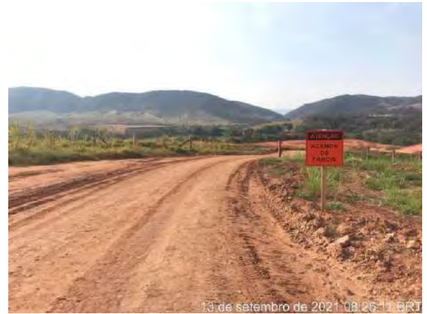
Foto 216 – Sinalização do acesso interno da obra. (Data: 13/09/2021)
