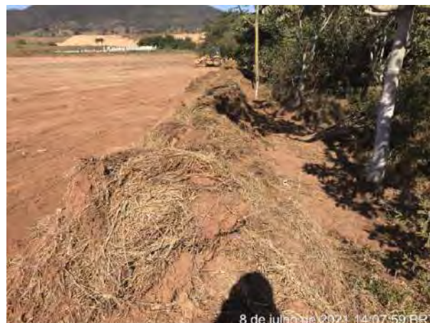
Foto 261 – Implantação de leira com gramíneas no entorno do Bota Fora 02. (Data: 08/07/2021)
