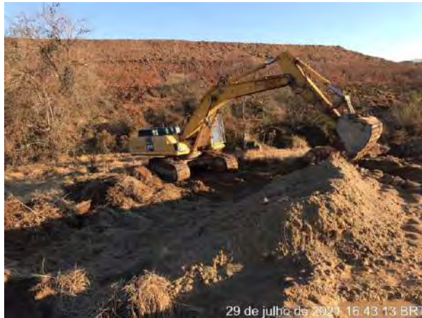
Foto 266 – Abertura de Cacimba de contenção Bota Fora 02. (Data: 29/07/2021)
