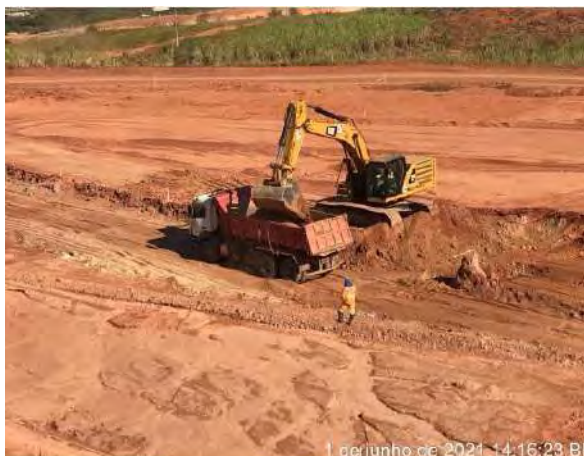
Foto 380 – Movimentação de terra na galeria, margem esquerda. (Data:01/06/2021)
