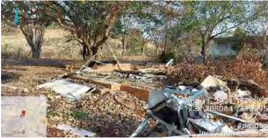
Foto 5. Pilha de entulhos com amianto.
