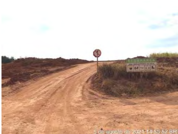
Foto 215 – Sinalização do acesso interno da obra. (Data: 05/08/2021)
