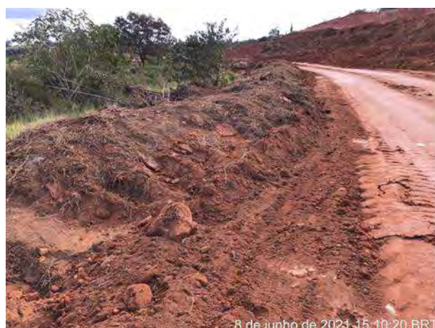
Foto 218 – Leira e disciplinamento para caixas de retenção. (Data: 08/06/2021)
