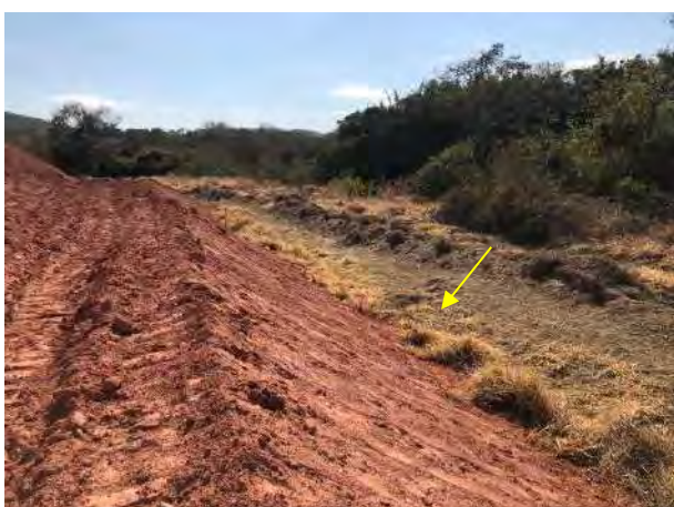
Foto 224 – Leira de proteção no entorno do bota espera com inclinação para a saia do talude. (Data:27/07/2021)
