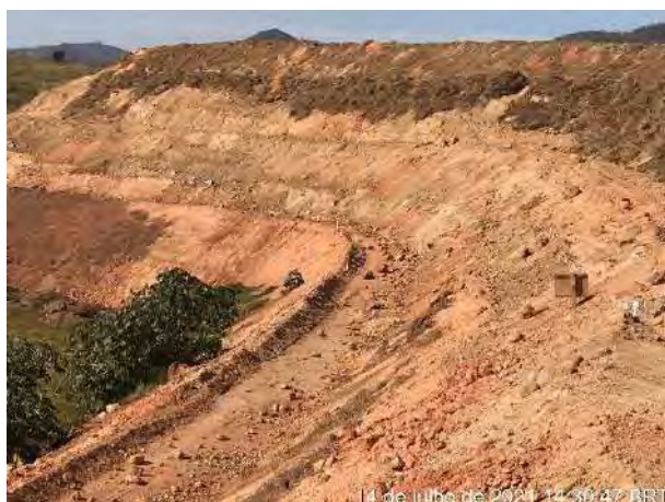
Foto 245 – Aplicação de biomassa no talude. (Data: 14/07/2021)
