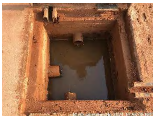
Foto 332 – Vistoria - Caixa SAO do tanque de combustível. (Data: 10/09/2021)
