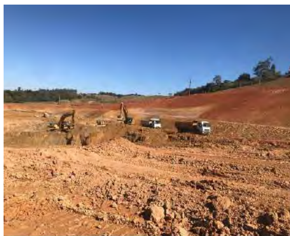
Foto 391 – Movimentação de solo Vertedouro. (Data:08/06/2021)
