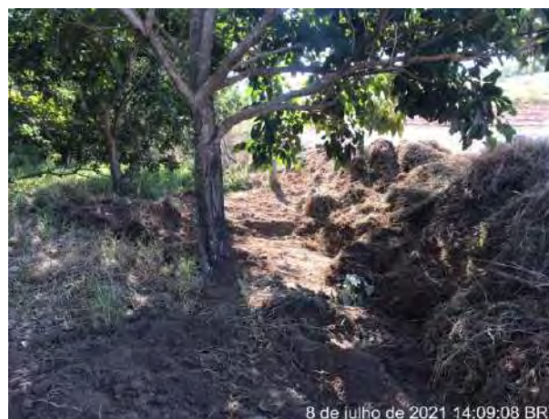
Foto 265 – Implantação de leira com gramíneas no entorno do Bota Fora 02. (Data: 08/07/2021)
