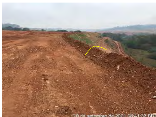
Foto 255 – Leira na crista para contenção de material e disciplinamento das águas pluviais. (Data: 10/09/2021)
