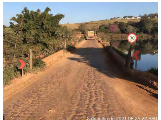
Foto 214 – Sinalização do acesso interno da Obra. (Data: 08/07/2021)
