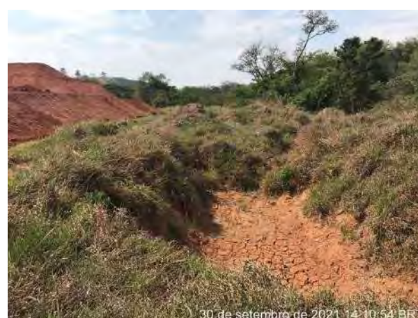
Foto 237 – Cacimba de retenção de particulado. (Data:30/09/2021)
