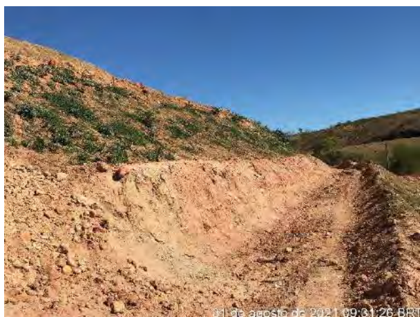
Foto 247 – Leira para retenção de material e disciplinamento do fluxo para as caixas de retenção. Bota Fora 01 (Data: 31/08/2021)
