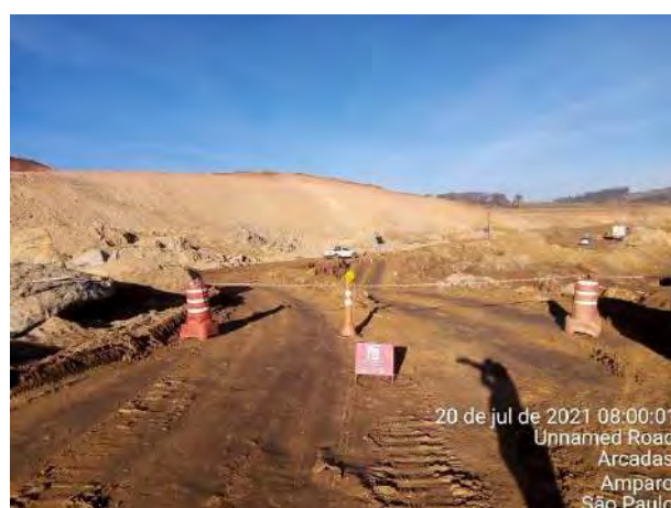
Foto 182 – Bloqueio da área de detonação. (Data:20/07/2021)
