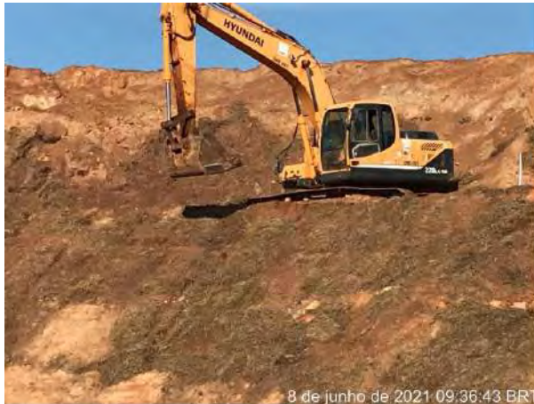
Foto 239 – Aplicação de biomassa no talude. (Data: 08/06/2021)
