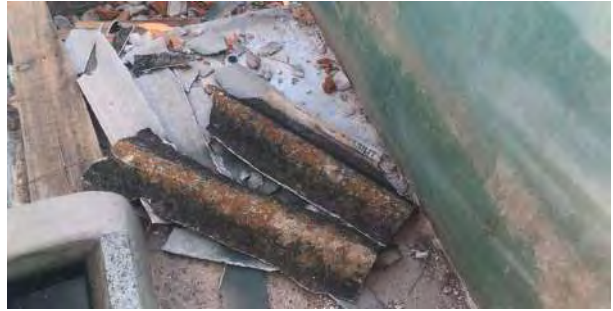
Foto 22. Fundos. Restos de telhas e discos de corte.
