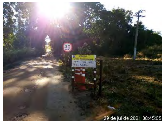
Foto 210 – Via municipal de acesso a obra. (Data:29/07/2021)
