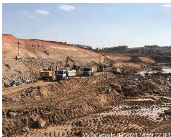
Foto 397 – Movimentação de terra na M.E Galeria. (Data:23/08/2021)
