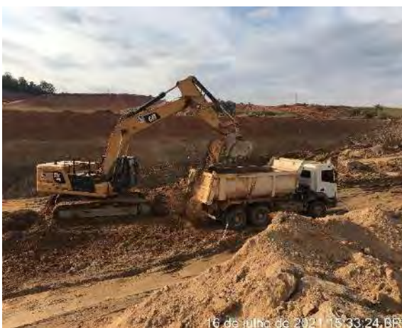
Foto 389 – Movimentação de terra na M.E Galeria. (Data:16/07/2021)
