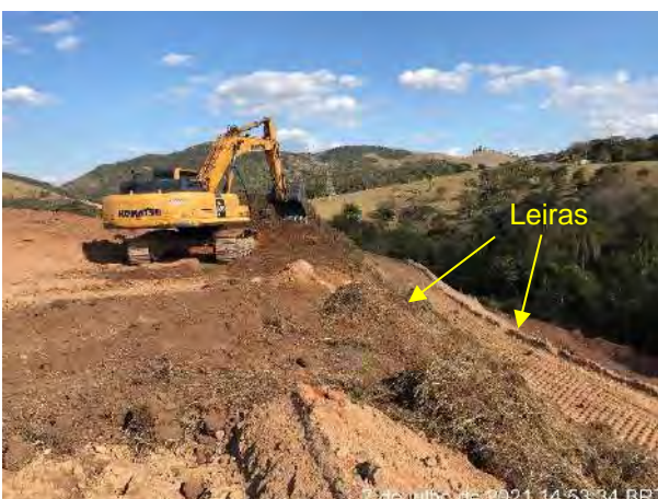
Foto 243 – Implantação de solo vegetal e leiras na crista. (Data:07/07/2021)
