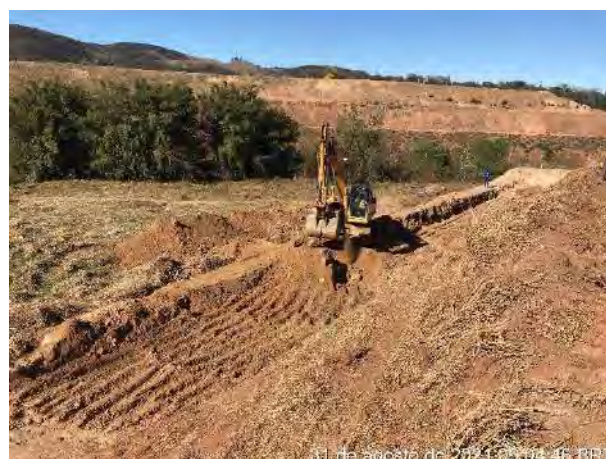
Foto 279 – Abertura de Cacimba de contenção Bota Fora 02. (Data: 31/08/2021)
