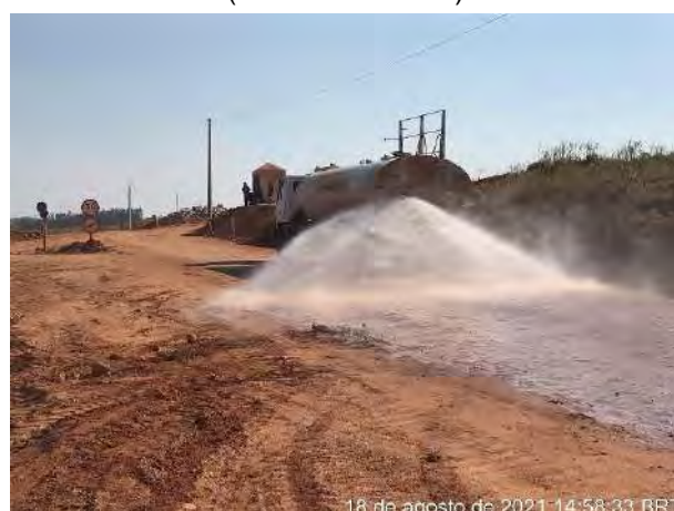
Foto 349 – Umectação de vias internas, MD vertedouro. (Data: 18/08/2021)
