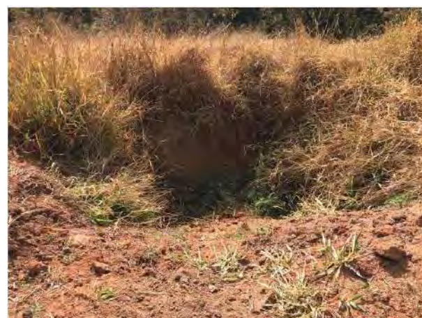
Foto 223 – Cacimba de retenção de particulado. (Data:27/07/2021)
