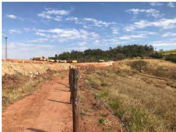
Foto 322 – Talude, leira e gramíneas, vista oeste face norte. (Data:27/07/2021)
