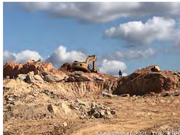
Foto 381 – Movimentação de terra na margem esquerda. (Data:17/06/2021)
