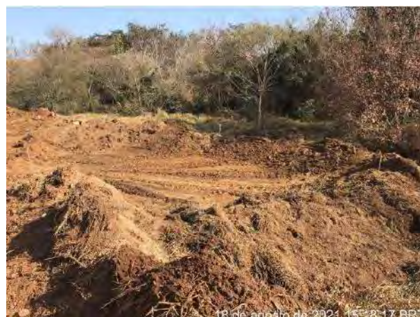
Foto 273 – Vista para a cacimba de retenção de sólidos. (Data: 18/08/2021)
