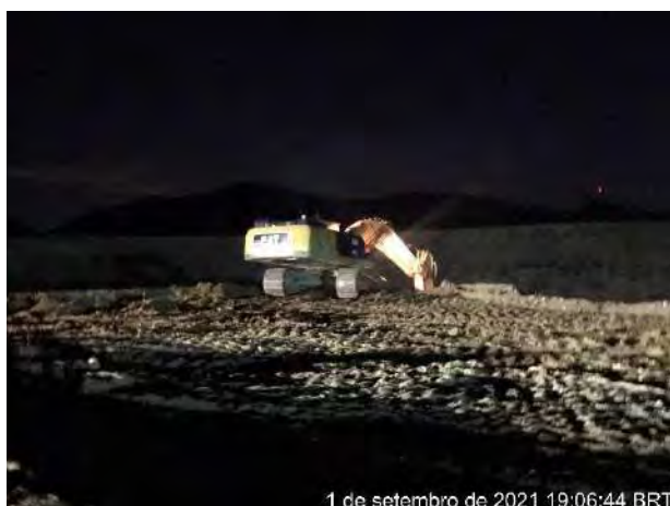
Foto 292 – Equipe do noturno aplicando dispositivos de drenagem. (Data: 01/09/2021)
