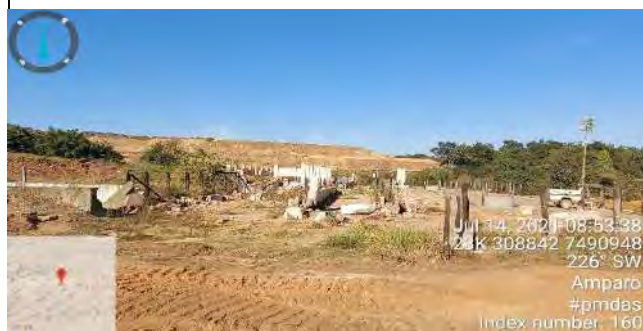
Foto 3. Visão geral das estruturas
