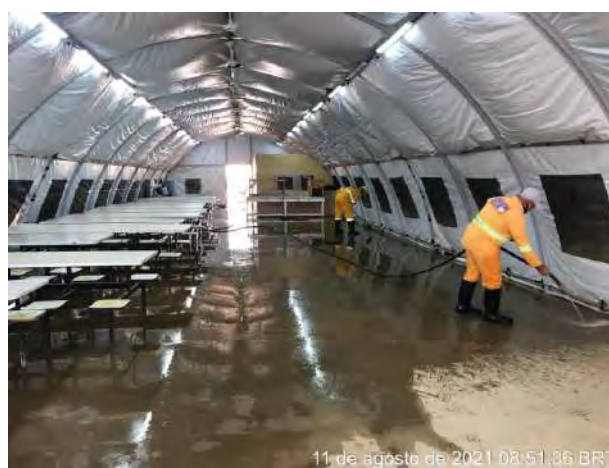
Foto 108 – Limpeza do refeitório no canteiro industrial. (Data:11/08/2021)
