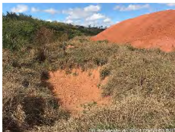
Foto 229 – Cacimba de retenção de particulado. (Data:30/08/2021)
