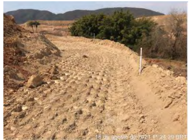
Foto 269 – Vista para as marcas no solo da compactação feita no local. 16/08/2021
