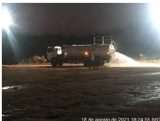
Foto 350 – Umectação do canteiro industrial. (Data:18/08/2021)
