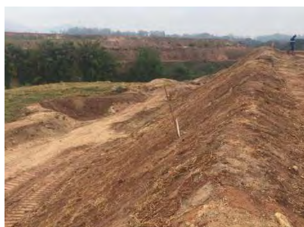
Foto 295 – Leira, cacimba, cobertura vegetal e disciplinamento de água. (Data: 30/09/2021)
