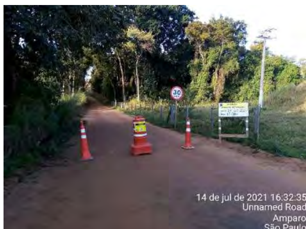
Foto 183 – Bloqueio de acesso. (Data:14/07/2021)
