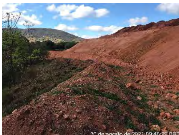
Foto 226 – Vista para inclinação e direcionamento do platô. Leira de solo entre as bermas do talude do bota espera. (Data:30/08/2021)
