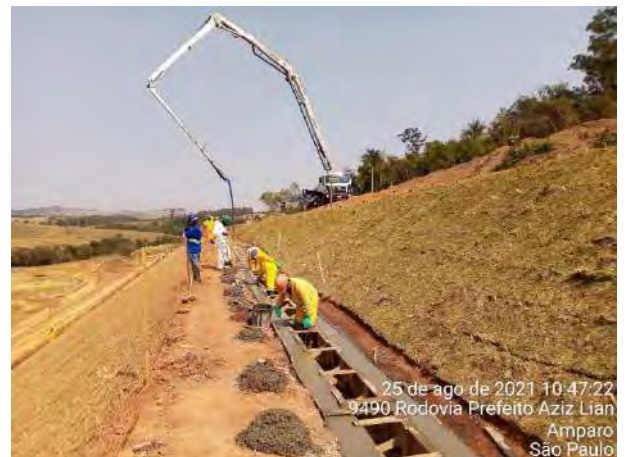
Foto 308 – Concretagem das canaletas de drenagem. (Data: 25/08/2021)
