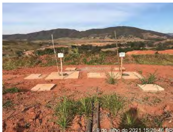
Foto 337 – Biodigestores do canteiro industrial. (Data: 19/07/2021)
