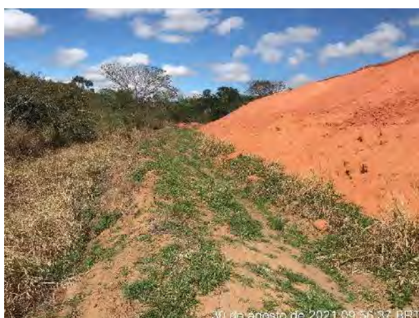
Foto 230 – Leira de proteção no entorno do bota espera com inclinação para a saia do talude. (Data:30/08/2021)
