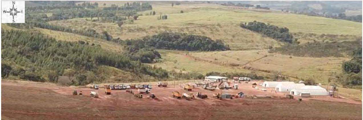
Foto 321 – Canteiro industrial. (Ilustrativo)
