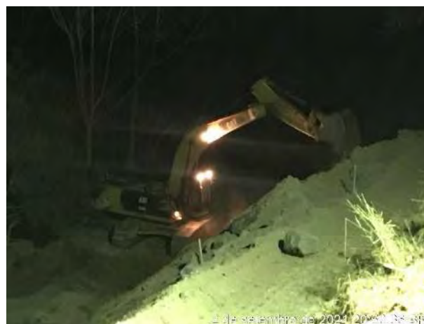
Foto 293 – Equipe do noturno reafeiçoando talude. (Data: 02/09/2021)
