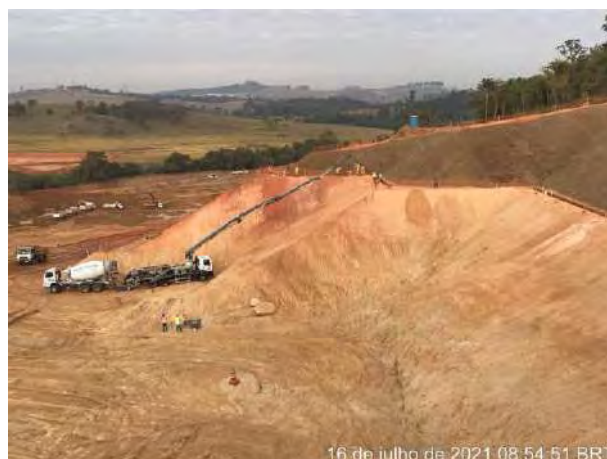
Foto 300 – Concretagem das canaletas de drenagem. (Data: 16/07/2021)
