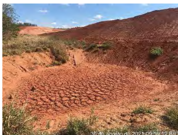
Foto 231 – Cacimba de retenção de particulado. (Data:30/08/2021)
