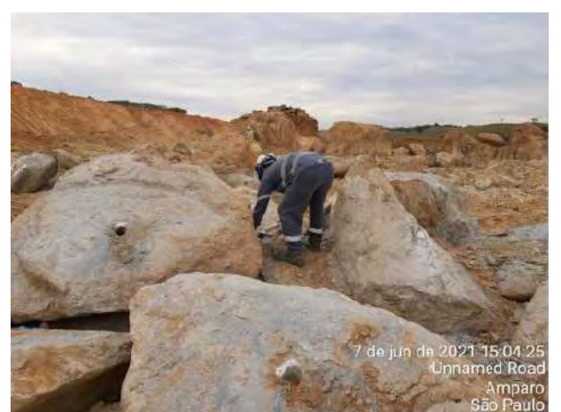
Foto 176 – Verificação dos furos. (Data:07/06/2021)
