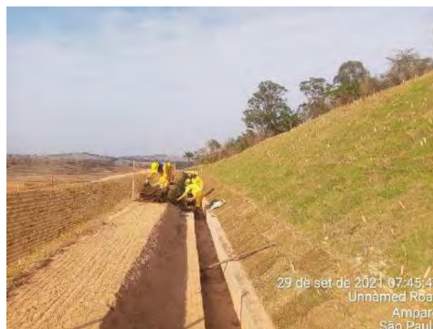
Foto 314 – Concretagem das canaletas de drenagem. (Data: 29/09/2021)
