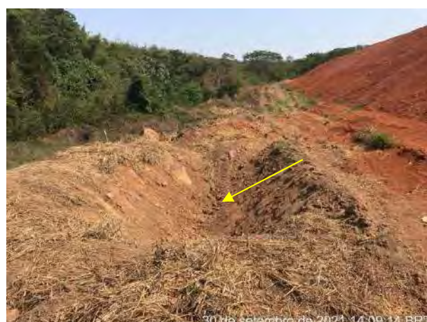
Foto 235 – Cacimba de retenção de particulado. (Data:30/09/2021)
