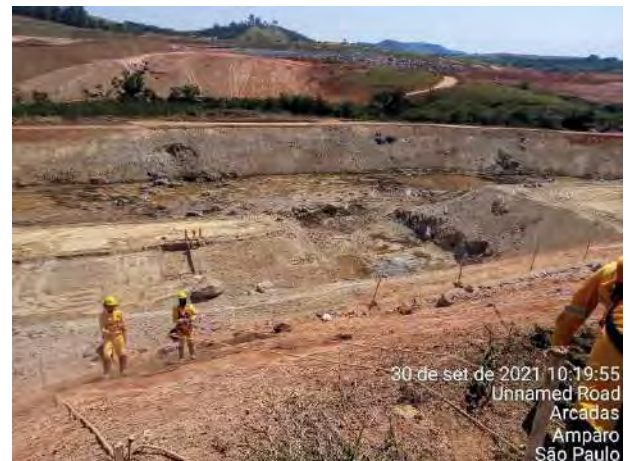
Foto 318 – Grama em placa e canaletas. (Data: 30/09/2021)
