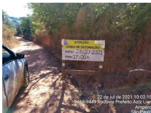
Foto 180 – Placa de aviso de detonação. (Data:22/07/2021)
