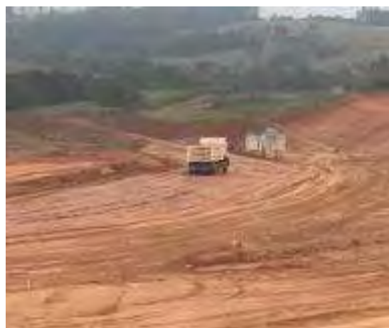
Foto 390 – Movimentação de solo vertedouro. (Data:20/07/2021)
