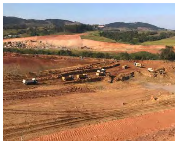
Foto 385 – Movimentação de terra Vertedouro. (Data:08/06/2021)
