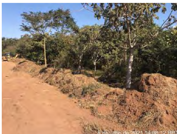
Foto 262 – Implantação de leira com gramíneas no entorno do Bota Fora 02. (Data: 08/07/2021)
