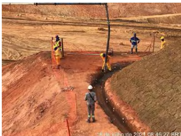
Foto 299 – Concretagem das canaletas de drenagem. (Data: 16/07/2021)
