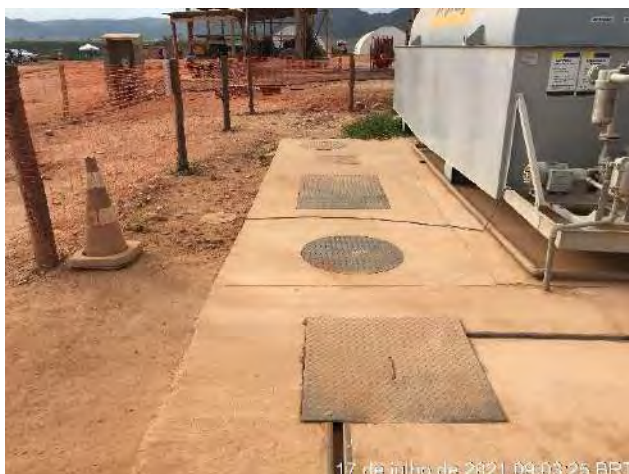
Foto 330 – Vistoria - Caixa SAO do tanque de combustível. (Data: 17/07/2021)
