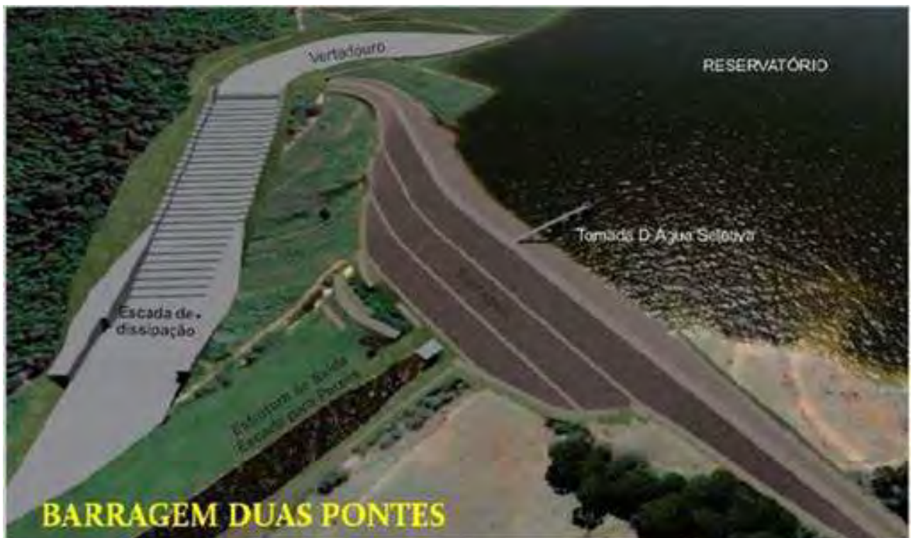
Figura 1 – Projeção da futura Barragem Duas Pontes
