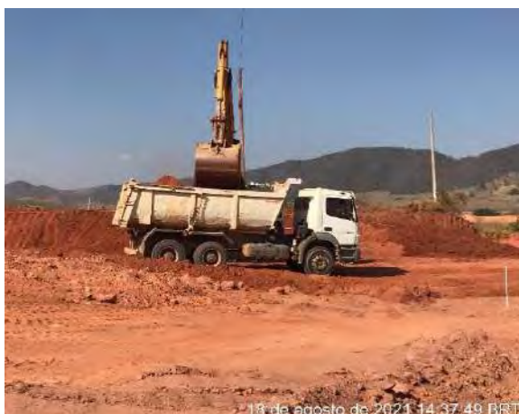
Foto 394 – Movimentação de terra na M.D Vertedouro. (Data:18/08/2021)
