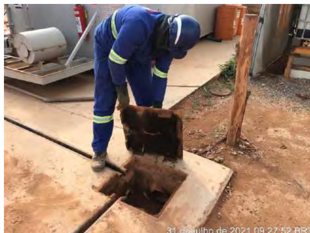
Foto 331 – Vistoria na 1ª Caixa de Inspeção e retenção de sedimentos. (Data: 31/07/2021)
