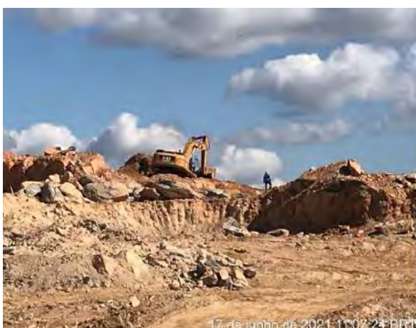
Foto 384 – Movimentação de terra M.D. (Data:17/06/2021)
