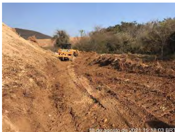
Foto 276 – Abertura de Cacimba de contenção Bota Fora 02. (Data: 18/08/2021)
