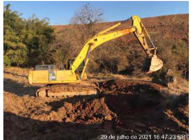
Foto 267 – Abertura de Cacimba de contenção Bota Fora 02. (Data: 29/07/2021)
