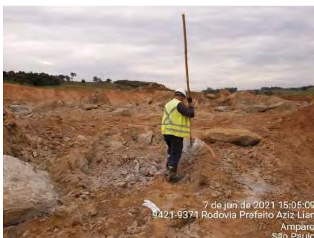
Foto 175 – Verificação dos furos. (Data:07/06/2021)
