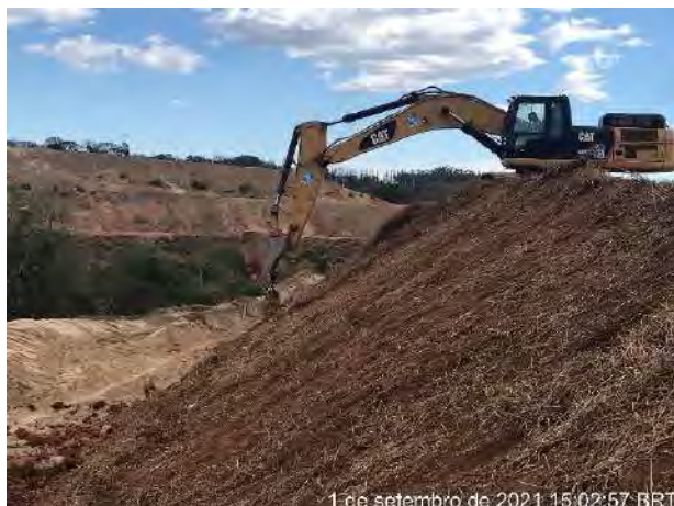
Foto 284 – Vista para equipe implantando gramíneas no talude. 01/09/2021
