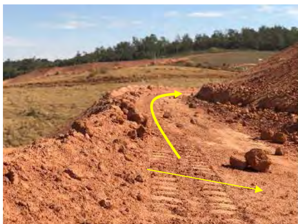
Foto 220 – Vista para inclinação e direcionamento do platô. Leira de solo entre as bermas do talude do bota espera. Data:27/07/2021)
