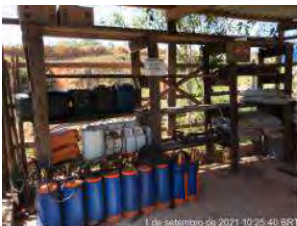
Foto 89 – Baia para armazenamento de produto químico. (Data:01/09/2021)
