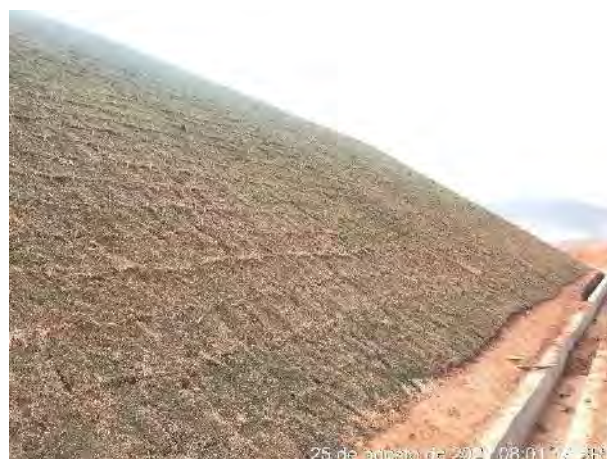
Foto 312 – Grama em placa e canaletas. (Data: 25/08/2021)
