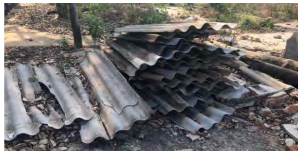
Foto 18. Telhas com amianto.
