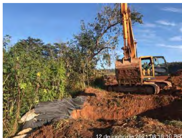
Foto 219 – Limpeza de cacimba. (Data: 12/06/2021)
