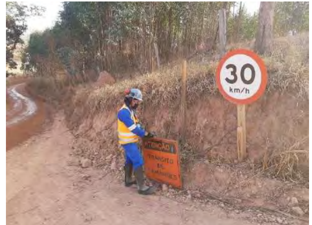
Foto 212 – Manutenção da placa de de acesso obra na via municipal. (Data:14/09/2021)
