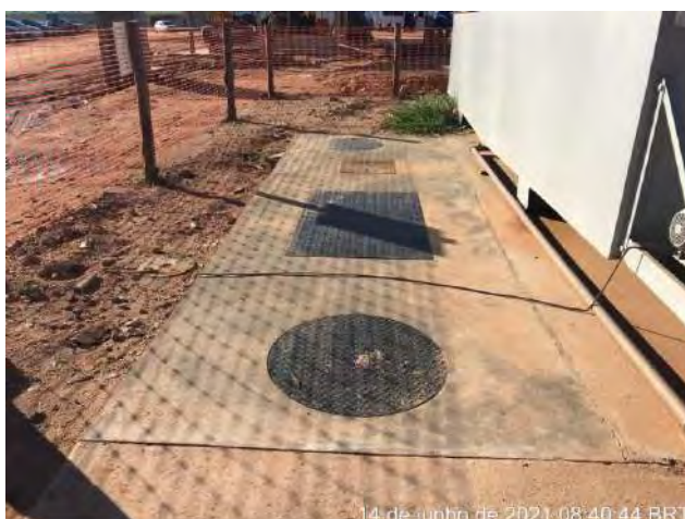
Foto 328 – Vistoria caixa SAO do tanque de combustível. (Data: 14/06/2021)
