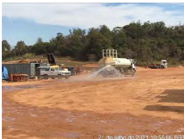
Foto 346 – Umectação do canteiro industrial. (Data:21/07/2021)
