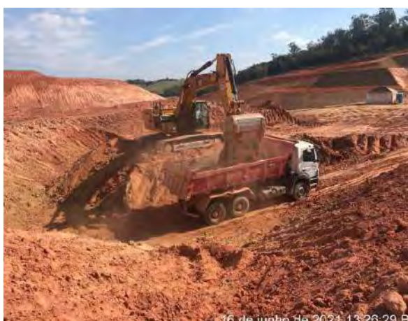
Foto 382 – Movimentação de terra na M.D Vertedouro. (Data:16/06/2021)
