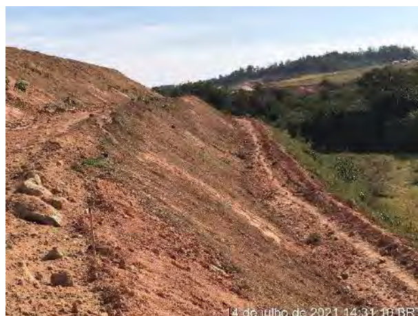
Foto 246 – Solo vegetal, leira e disciplinamento para caixas de retenção. (Data: 14/07/2021)
