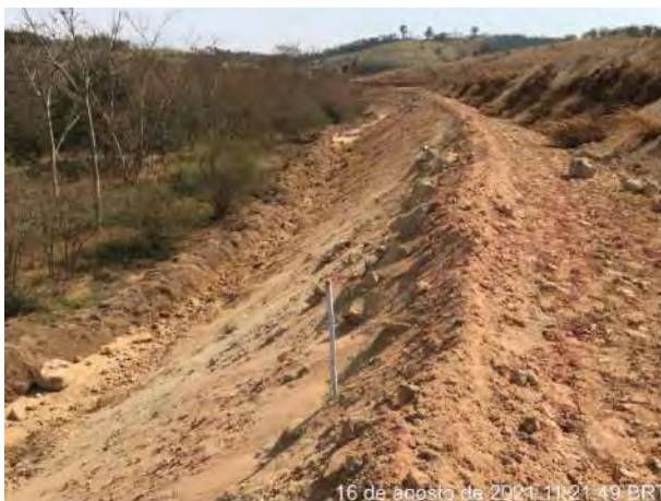
Foto 270 – Vista para leira de proteção e canaletas com gramíneas no pé do talude. 16/08/2021
