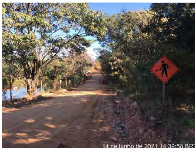
Foto 213 – Sinalização do acesso interno da Obra. (Data: 14/06/2021)
