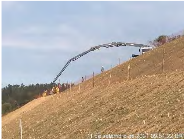
Foto 317 – Germinação grama em placa e canaletas. (Data: 11/09/2021)
