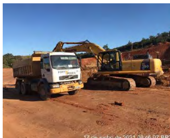
Foto 383 – Movimentação de terra na M.D Vertedouro. (Data:17/06/2021)
