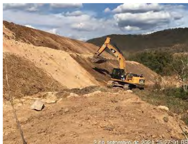
Foto 283 – Equipe implantando solo vegetal nos taludes. 02/09/2021
