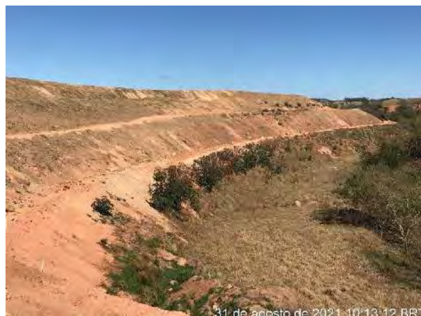
Foto 252 – Solo vegetal, leira e disciplinamento para caixas de retenção. (Data: 31/08/2021)
