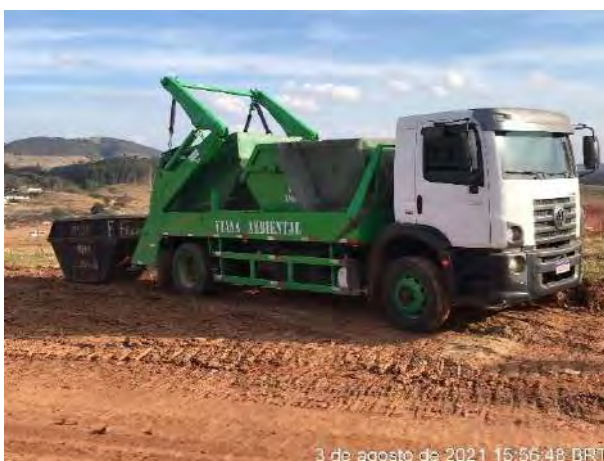
Foto 378 – Troca da caçamba de resíduo comum do canteiro industrial (Data: 03/08/2021)
