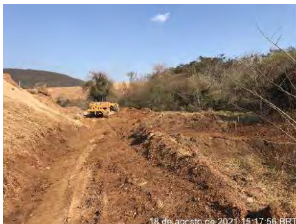
Foto 272 – Manutenção das leiras e canaleta com retirada de solo carregado após chuva. Destaque para as contenções que foram eficientes. Sem extravasamento. (18/08/2021).
