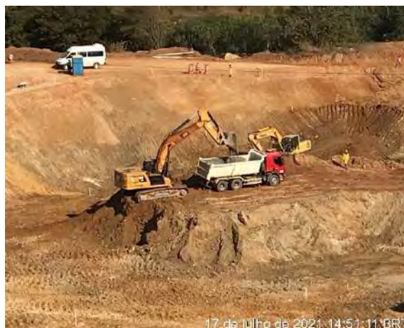
Foto 387 – Movimentação de terra na M.D Vertedouro. (Data:17/07/2021)
