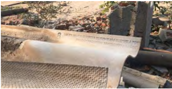
Foto 17. Telhas com amianto.
