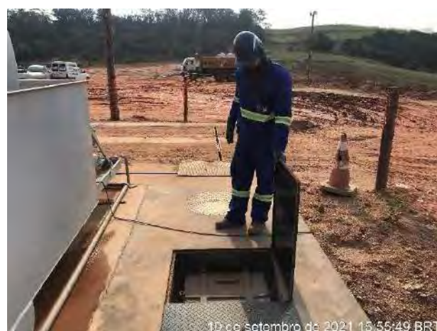
Foto 333 – Vistoria - Caixa SAO do tanque de combustível. (Data: 10/09/2021)
