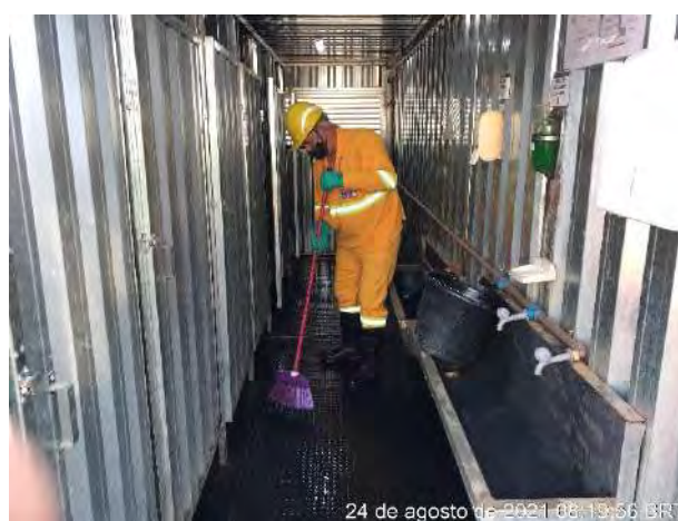
Foto 110 – Limpeza do banheiro no canteiro industrial. (Data:24/08/2021)
