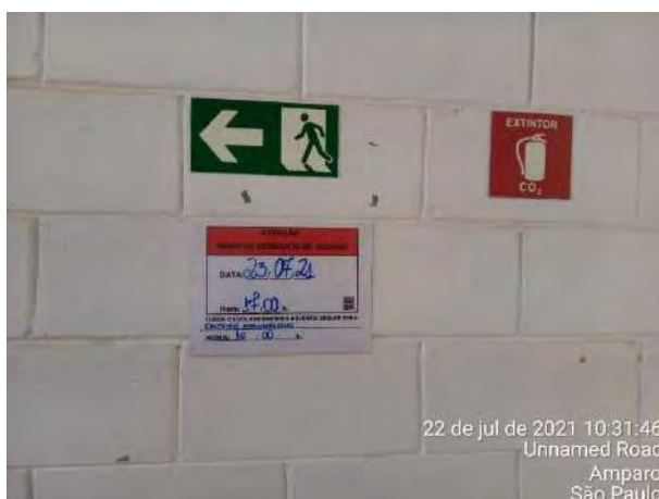
Foto 179 – Placa de aviso interno de detonação. (Data:22/07/2021)
