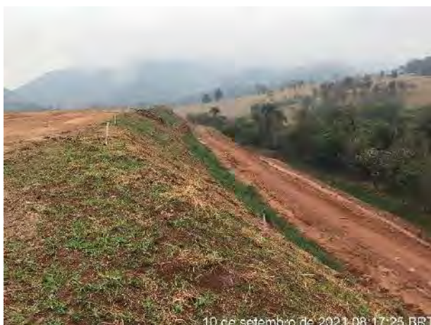
Foto 253 – Leira para retenção de material e disciplinamento do fluxo para as caixas de retenção. Bota Fora 01 (Data: 31/08/2021)
