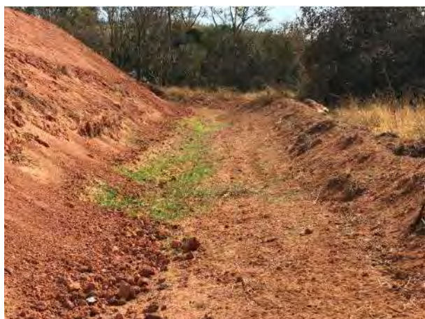
Foto 222 – Canaleta e leira no entorno da bota espera. (Data:27/07/2021)
