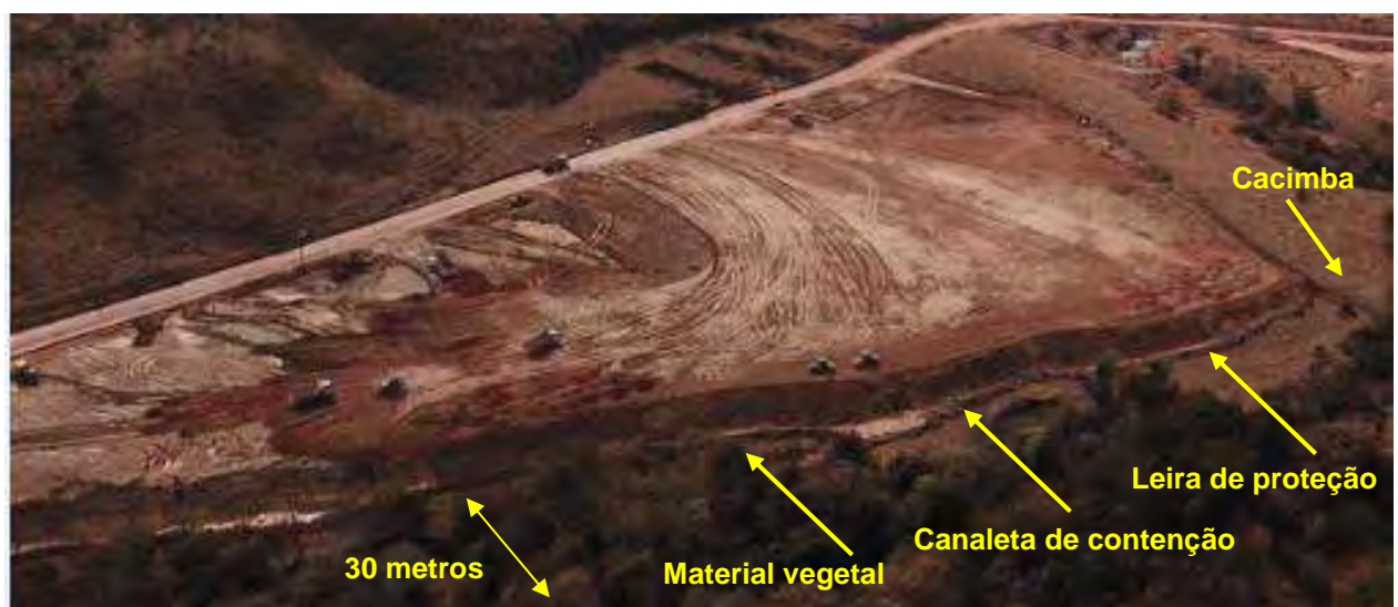
Foto 259 – Bota Fora 2, vista para proteções preventivas em seu entorno.
