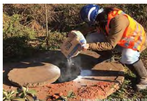
Foto 4. Sanitização da fossa
