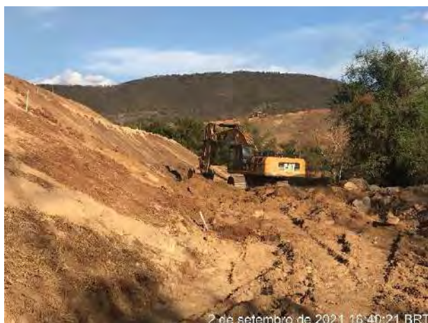
Foto 290 – Equipe abrindo cacimba de retenção de sólidos. (Data: 02/09/2021)
