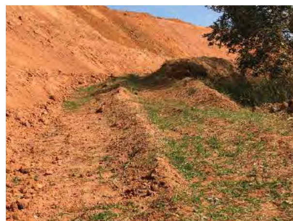
Foto 225 – Gramíneas crescendo na leira de proteção no entorno do bota espera. (Data:27/07/2021)
