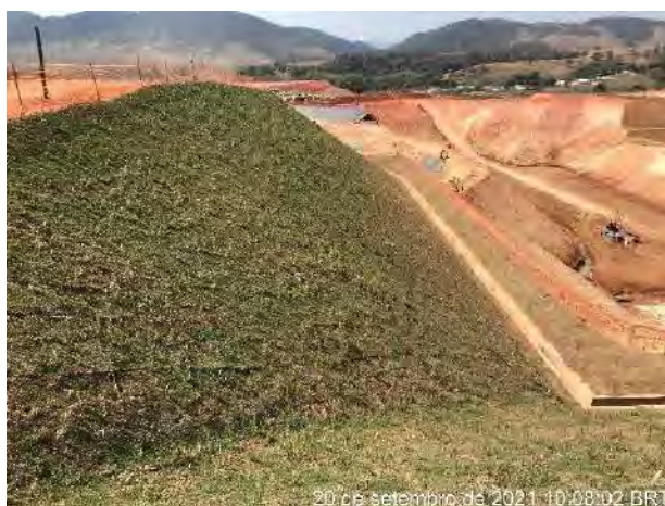
Foto 313 – Abertura das canaletas de drenagem. (Data: 20/09/2021)
